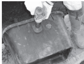
・配管用の穴をあける
