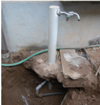
水栓の周りを掘り配管を見つける
