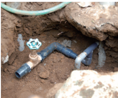
止水栓を設置
