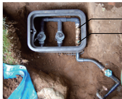
電磁弁をボックス内に設置
