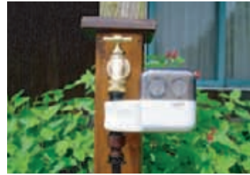
立水栓に設置
