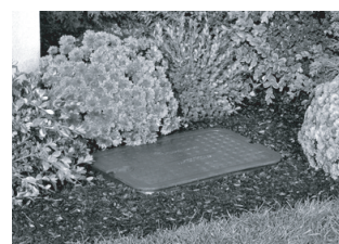
・インラインバルブをボックスの中に設置する。水はけ用にバルブの下に砂利を敷くことをおすすめします。
