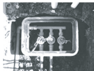
・インラインバルブをボックスの中に設置する。水はけ用にバルブの下に砂利を敷くことをおすすめします。
